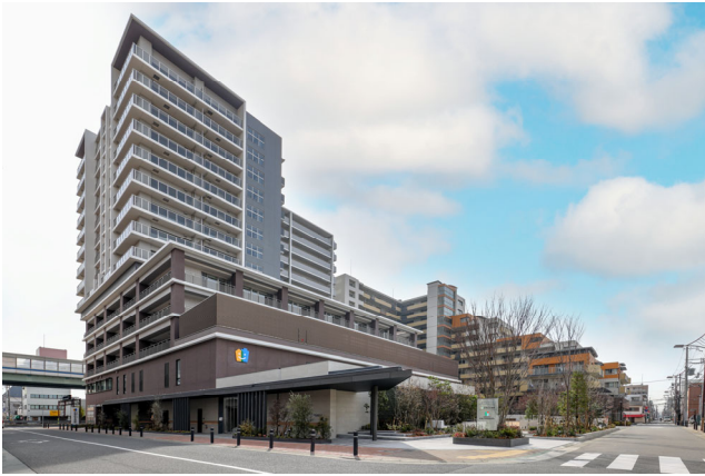
北東側の外観
