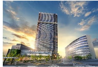
ジオタワー大阪十三（2026年1月竣工予定）
